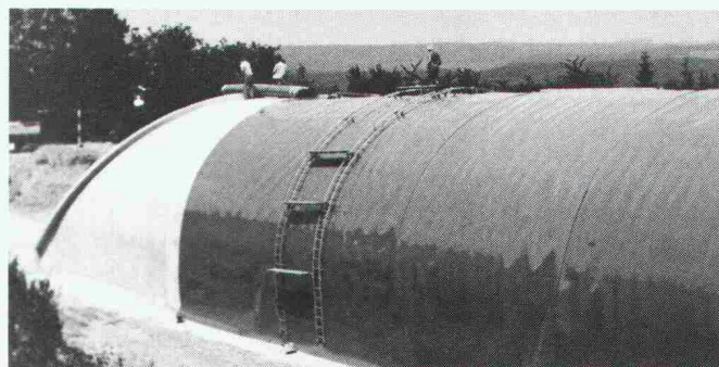
Tunnel «Nordumfahrung Zuzach» – zur Zeit in Ausführung: abgedichtet mit 30 000 m 2 Sarnafil Typ FP 4 mm.
