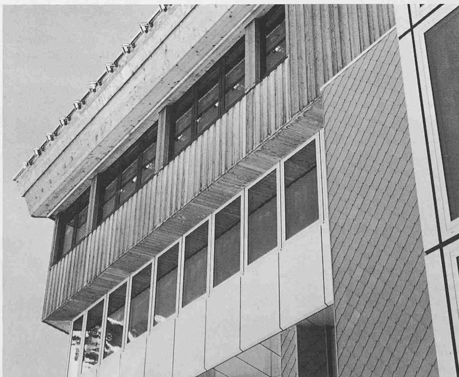
Fassadenausschnitt Ecke Südwest
