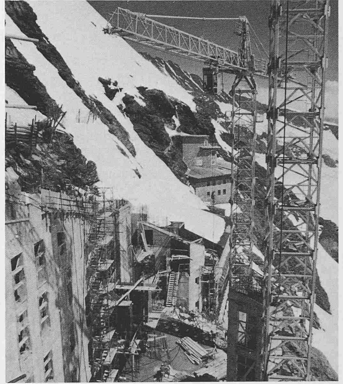
Zwei speziell für das Jungfrauojoch konstruierte Baukrane wurden – wie alle andern Bauteile in kleine Elemente zerlegt – mit der Wengernalpbahn und der Jungfraubahn auf 3450 m Höhe transportiert. Für den Kranführer eine verantwortungsvolle Aufgabe hoch über dem Aletschgletscher; die Höhe des Aufstiegs über die vereiste Stahlleiter zur Krankabine unterstrich diese Verantwortung
