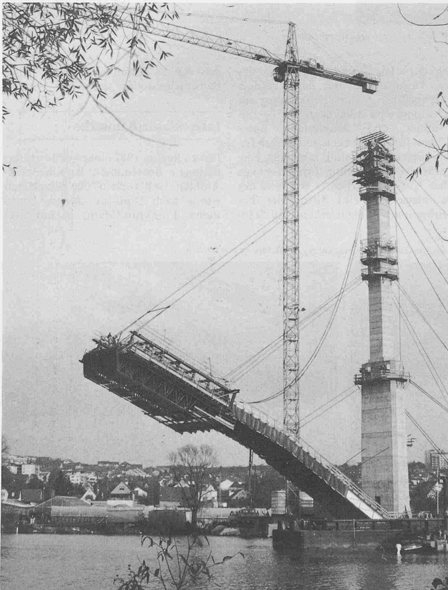
Bild 8. Zweigleisige Eisenbahnbrücke in Veitshöchheim für die Neubaustrecke Hannover-Würzburg. Herstellen des Bogens im Freivorbau mit Abspannungen zu Hilfspylonen.
