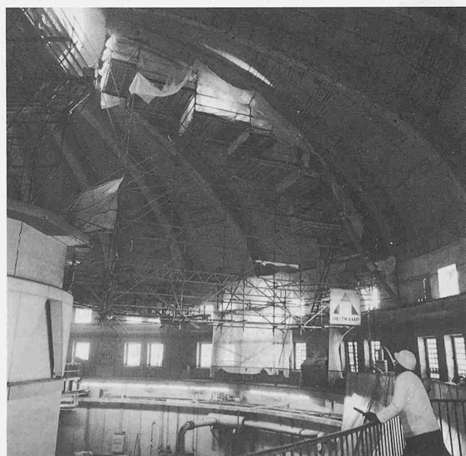
Bild 6. Kuppelbau eines alten Pumpwerkes in Duisburg vor (a) und nach der Instandsetzung der Stahlbetonninnenseite (b)
