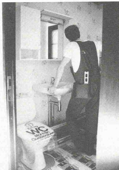
Bild 3. Installations- und Apparateeinbau im Werk
