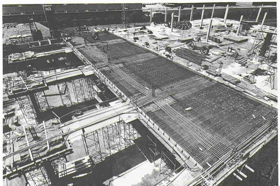
Bild 6. Ansicht einer Betonieretappe 15,40×56,40 m (ohne obere Armierung)
