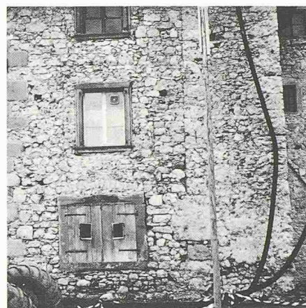
Bild 1. Diese freigelegte Fassade offenbart ein Stück Baugeschichte. An- und Umbauten werden erkennbar. Als Ecksteine dienten Tuff, Alpenkalk und Molassesandstein. (Winkelriedhaus Stans, Juli 1987)
