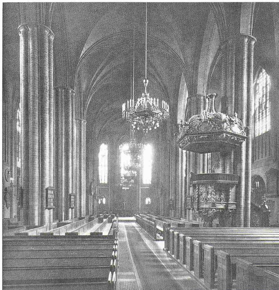
Die Nikolaikirche vor der Zerstörung, Hauptschiff
