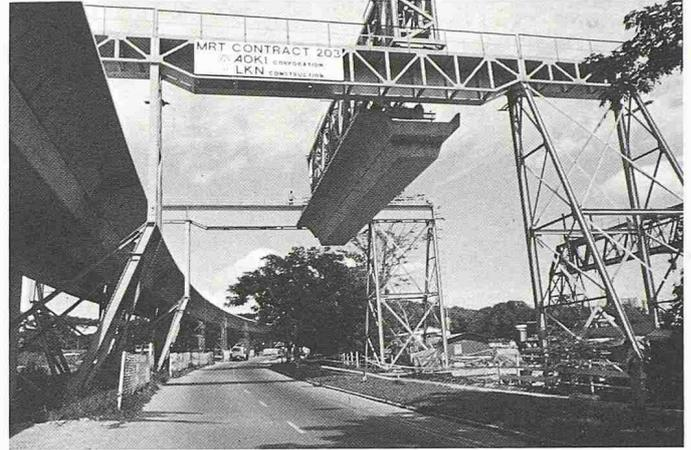
Bild 3. Brückenträger wird über die Strasse transportiert
