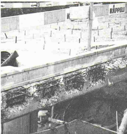
Bild 8. Enge Platzverhältnisse auf der Bankettseite
