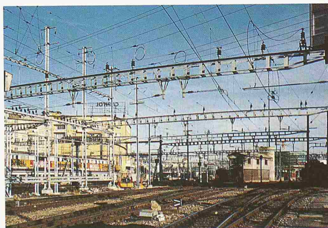
Bild 3. Schaltposten im Bahnhof Luzern im Bau. Die einzelnen Sektoreinspeisungen sind vorbereitet (Ringe an Quersaiten) (Foto J. Brun, Luzern)
