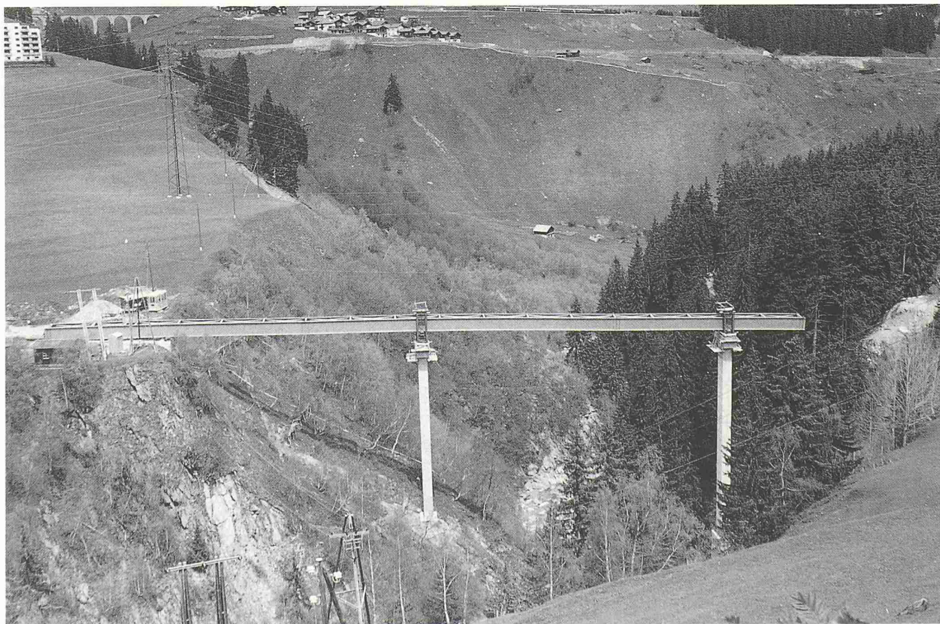
Bild 1. Ansicht der Baustelle
