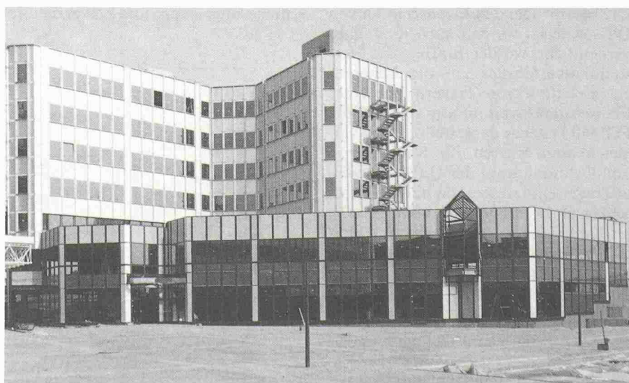
Bild 16. Data Processing Center in Luxemburg
