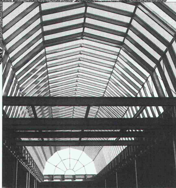
Stahl- und Industriebau
