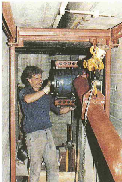
Bild 16. Vorspannung Überbau, Spannen der Kabel bei den Widerlagern Bildautor: K. Lüpold VSL
