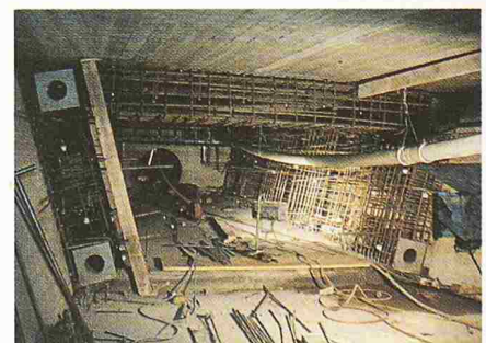
Bild 13. Verstärkung Überbau, Armierung Vorspannung Bildautor: A. von Glutz
