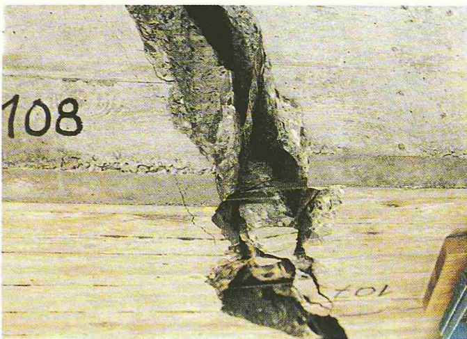
Bild 2. Sicherung Überbau Bildautor: A. von Glutz
