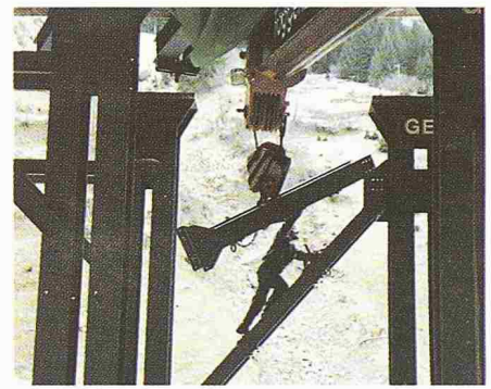
Bild 9. Montage der Querverstrebungen Bildautor: A. von Glutz
