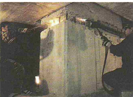
Bild 14. Wärmen und Trennen der Zugarmierung (A. von Glutz)
