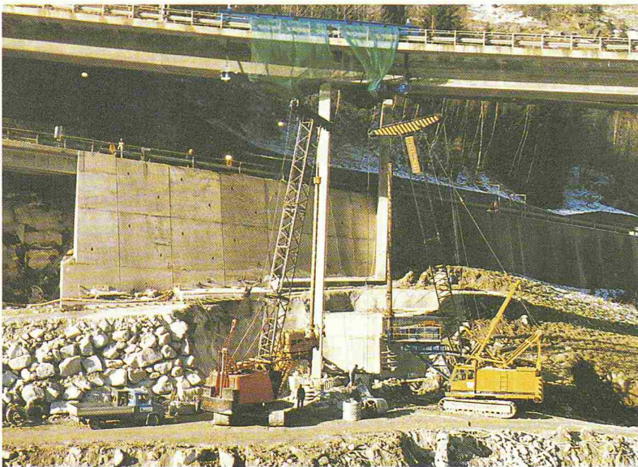
Bild 5. 2 Bohrgeräte beim Pfählen (A. von Glutz)
