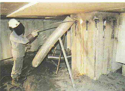
Bild 15. Abschmelzen der Druckzone im Pfeiler (L. Buscarlet)
