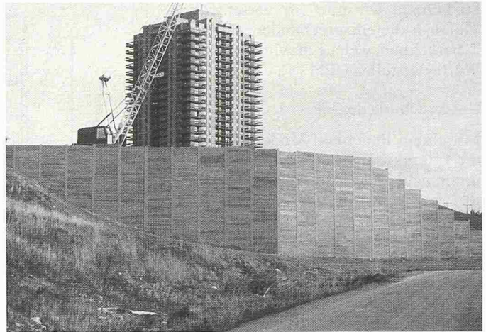
Stützkonstruktion verstärkt mit Geogittern, Front mit Holzelementen, Calgary (Alberta)
