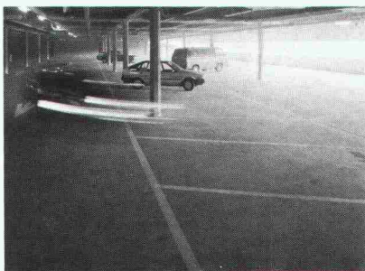
Parkdeck Glattzentrum, Wallisellen
