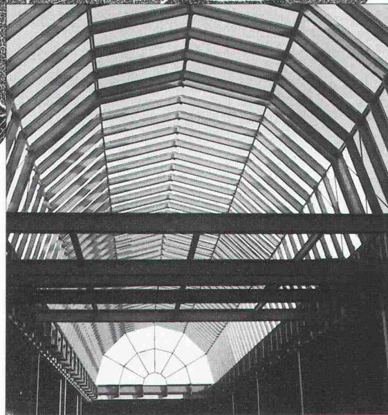
Stahl- und Industriebau
