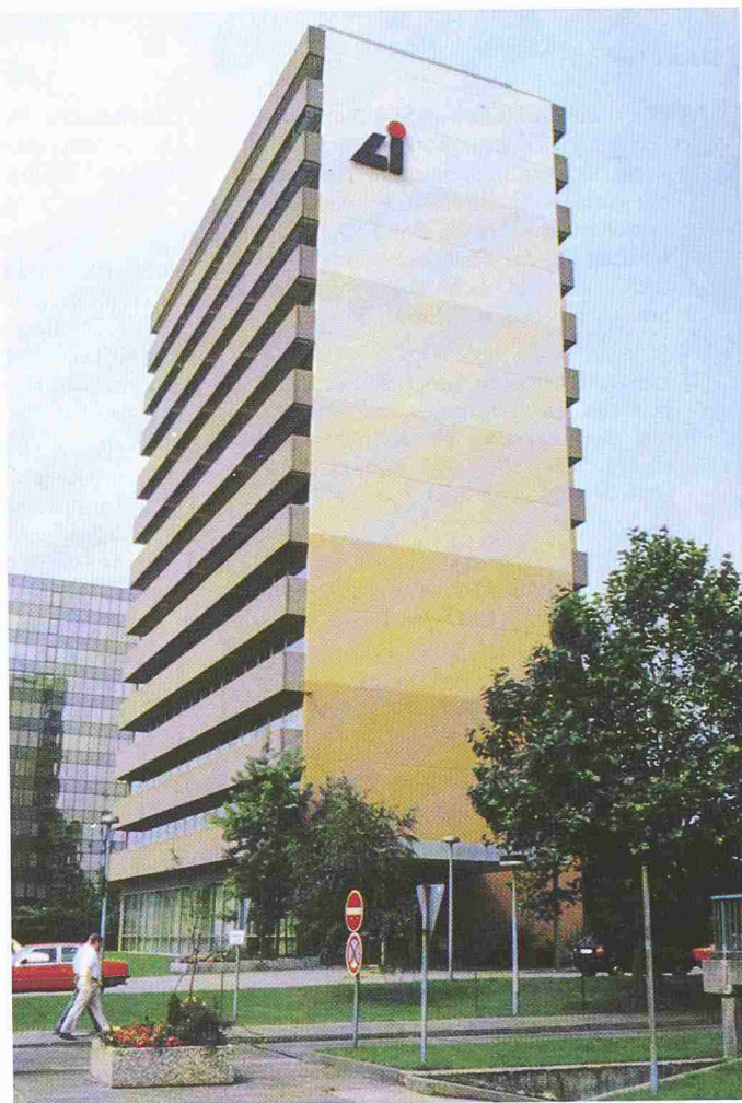
Bild 2. Verwaltungsgebäude nach der Instandsetzung der Sichtbetonflächen (2500 m 2 ) und Anbringen eines Oberflächenschutzes mit Farbzusatz (Jacobi)
