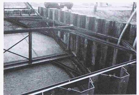
Bild 9. Oberwasserkanal im Bereich des Pfeilers 3 Nord mittels speziellem Fangdamm trockengelegt. Deutlich sind die Betonplatten der Kanalauskleidung ersichtlich
