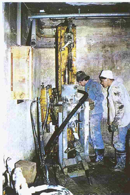
Bild 2. Unterquerung der Rämistrassenhäuser
