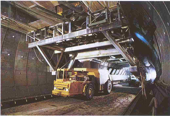
Bild 8. Verlad des Ausbruchs im Zürichbergtunnel
