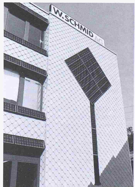
Bild 3. Die Solarzellen sind einerseits an Sturze und Bänke der Fenster montiert, andererseits in die Fassade integriert
