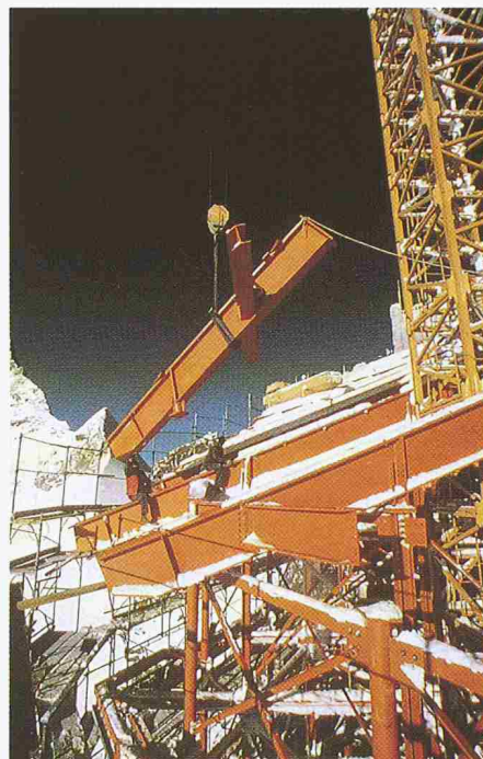
Bild 2. Auch unter schwierigsten Witterungsbedingungen lassen sich Verbundbauten sicher und schnell erstellen, wie dieses Bild von der Montage des «Top of Europe» in 3500 m Höhe auf dem Jungfrauoch beweist.
