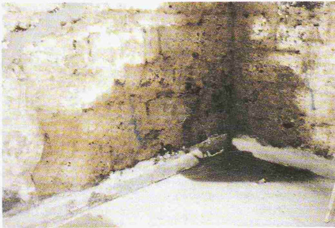
Bild 2. Mauerwerkschaden durch aufsteigende und hygroskopische Feuchtigkeit
