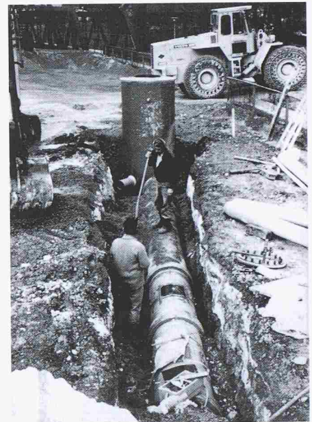
Bild 1. Versuchsrohrleitung in der Einfahrt zum Kiesdepot der Kalkfabrik in Netstal (Bauzustand). Vorne: Kontrollschacht DN 1200 mm mit Kanalrohrleitung DN 600 mm und Kraftmessfenster; im Hintergrund: schwere Muldenkipper (spätere Verkehrslast)
