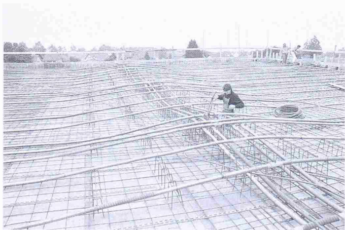
Bild 3. Vorspannbewehrung der Decken
