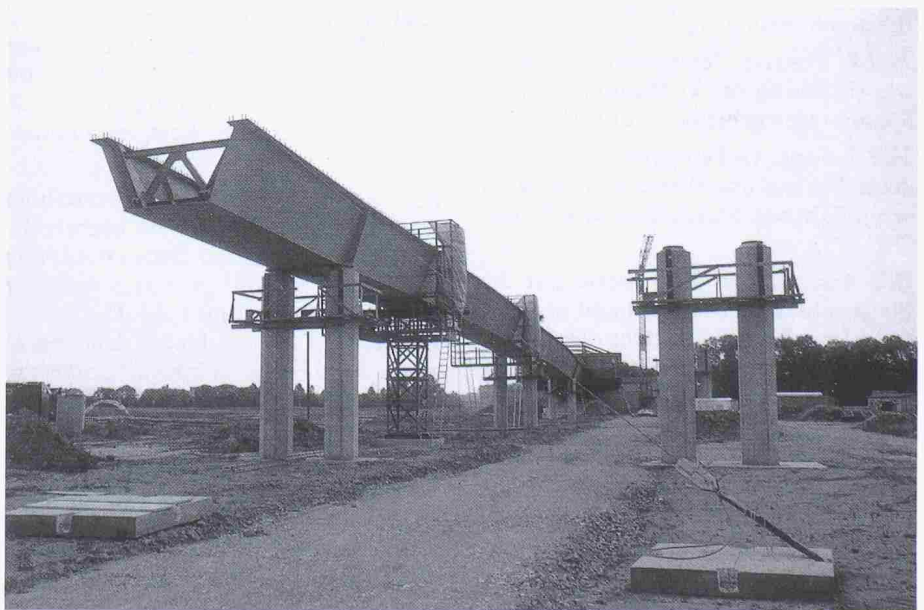
Bild 5. Viadukt «Bois de Rosset» während der Montage
