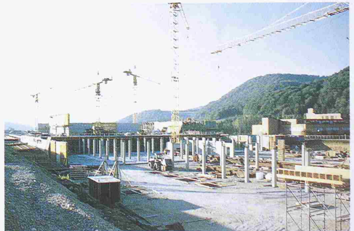
Bild 7. IKEA, Rohbau Blocklager
