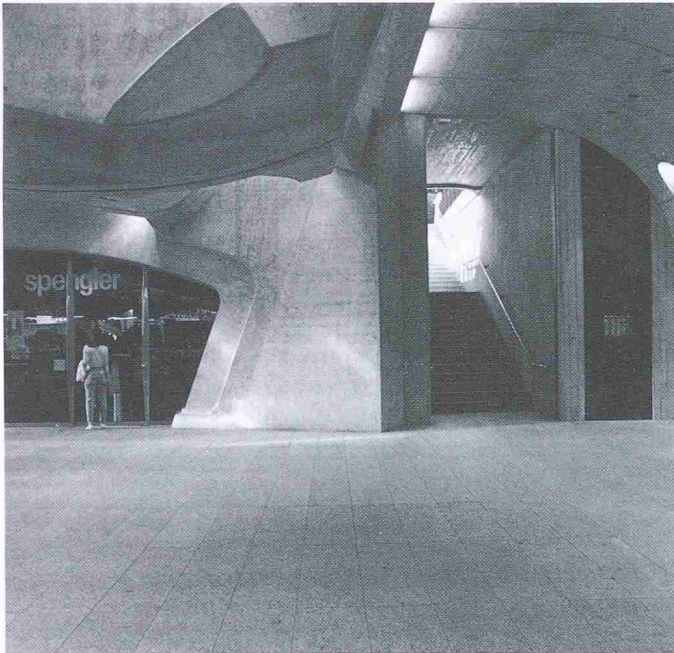
Bild 5. Untergeschoss: Stützen des Gleistroges, Durchlass des Tageslichtes
