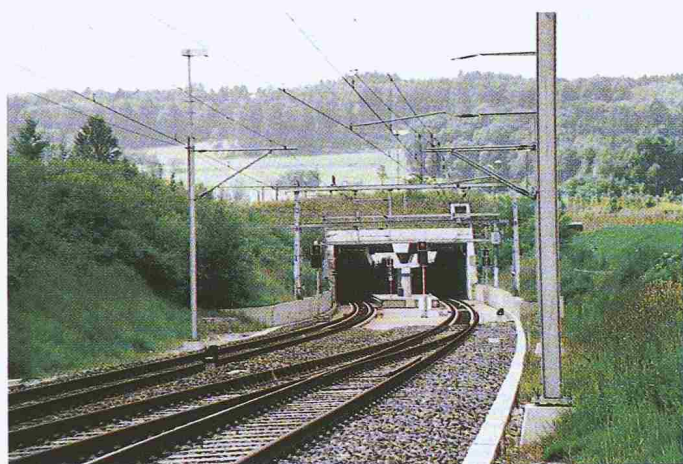
Bild 4. Portal Zürichbergtunnel/Station Stettbach
