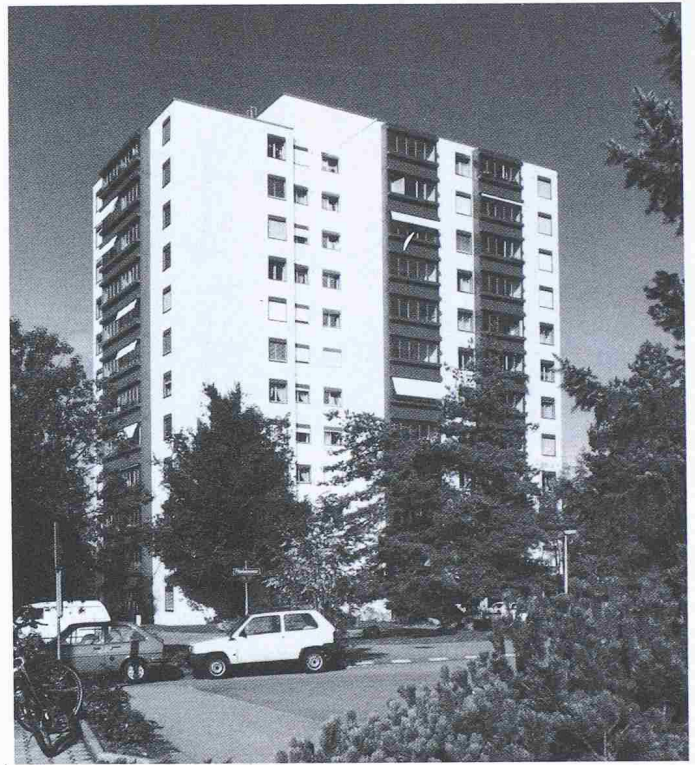
Bild 1b. Zustand nach der Fassadensanierung. Massgebend für die Auszeichnung war neben der Sanierung der Haustechnik die gute konstruktive Lösung der hinterlüfteten Fassade mit Keramikplattenverkleidung sowie die Integration der Balkone mit Fallfenstern
