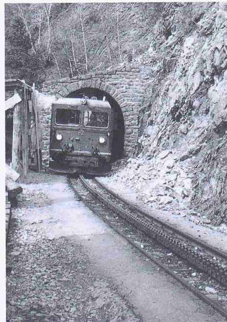
Bild 1. Enge Platzverhältnisse beim Portal
