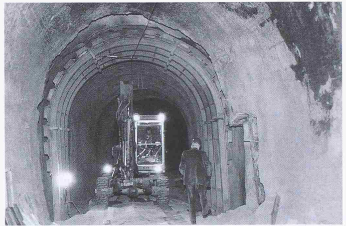
Bild 9. Stahlschutzschild im Bereich eines frisch ausgeweiteten Abschnitts
