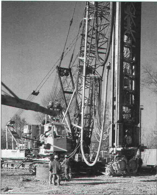
Schlitzten mit der Hydrofräse „im Cher“ in Opfikon/Glattbrugg in ARGE ausgeführt.
