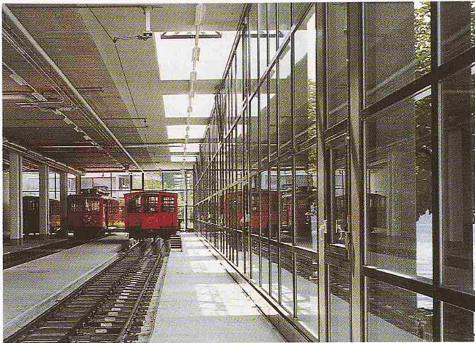
Blick in die transparente, vollflächig verglaste Depothalle
