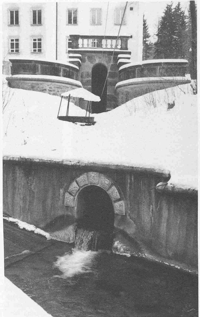
Bild 28. Kette von industriegeschichtlich wertvollen Zeugen des Industrie-Ensembles Neuthal: Wissenbach mit Krügelbach-eindolung, gedeckter Einstieg zum Kontrollschacht des Turbinenauslaufstollens vom Fabrikgebäude, Transmissionsschlitz als integraler Bestandteil der früheren Parkanlage sowie im Hintergrund ein Teil des kürzlich durch den Kanton erworbenen Fabrikgebäudes
