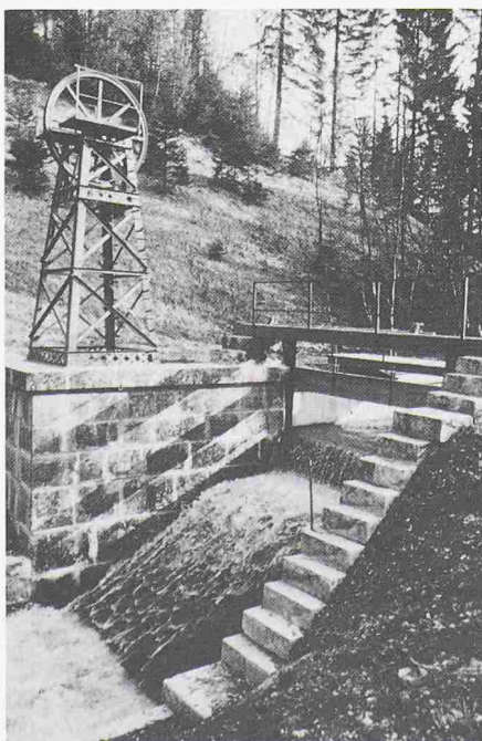
Bild 24. Unteres Wehr am Wissenbach mit Zwischenstütze der Seiltransmission, noch vor der Seilmontage
