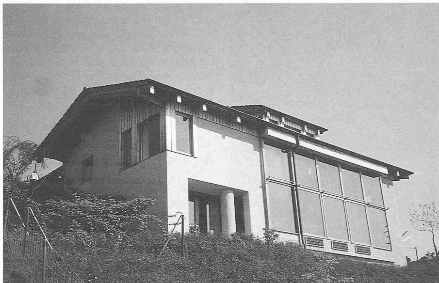
Bild 3. Südwestansicht mit dem Fensterkollektor
