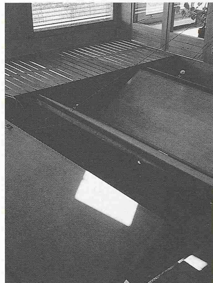
Bild 4. Im Wintergarten. Die begehbare Abdeckung über dem Schwimmbad ist halb geöffnet. Unter dem Rost befinden sich die Fischtanks
