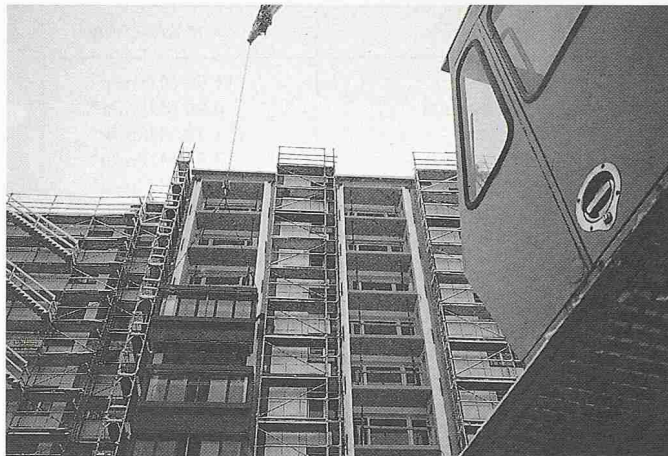
Bild 5. Versetzen der Balkonerker im November 1988
