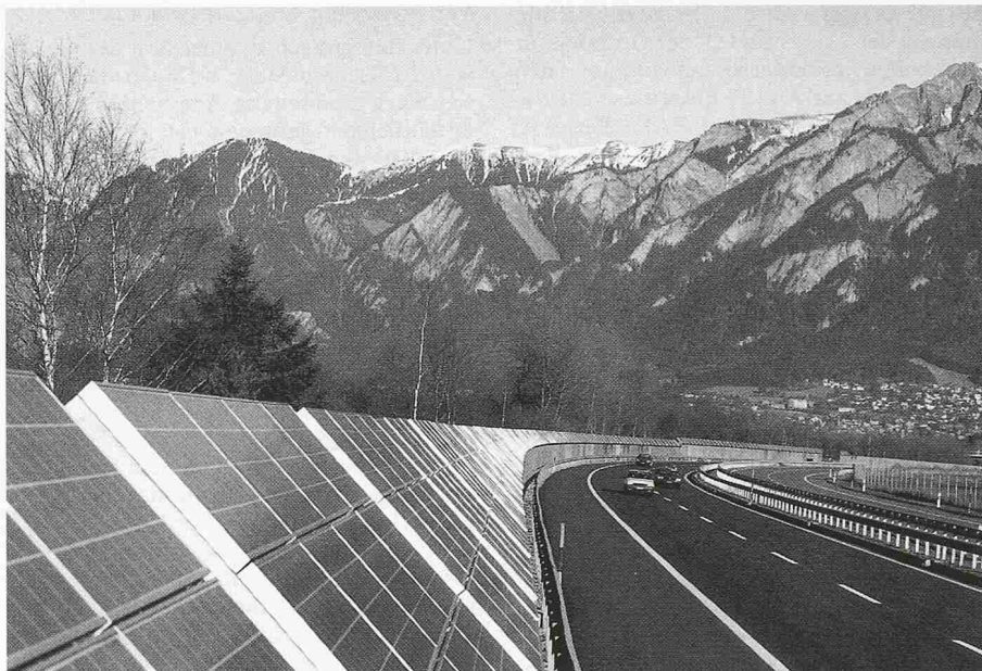
Bild 1. Das zurzeit grösste Photovoltaik-Panelfeld der Schweiz entlang der Autobahn N13 im Bündnerland
