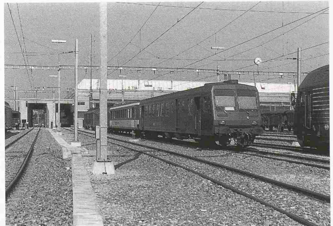
Bild 3. Links im Bild sind die Reinigungsanlagen erkennbar
