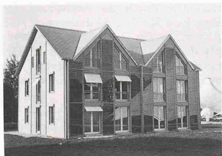
Das Null-Heizenergie-Haus, am Rande der Ausstellung, aber viel beachtet (Bild: M. Burkhard)
