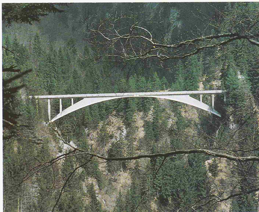
Salginatobelbrücke, 1930. Ansicht aus der Nähe. Man erkennt das Gelenk im Bogenscheitel, die kleinen Vouten des Fahrbahnträgers in den Übergängen zu den Querwänden und den Bogen, der zu den Kämpfergelenken hin an Höhe verliert
