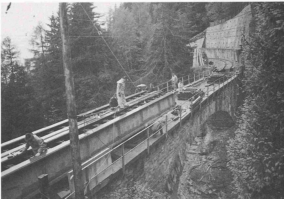
Bild 3. Einschub der Hilfsbrücke
