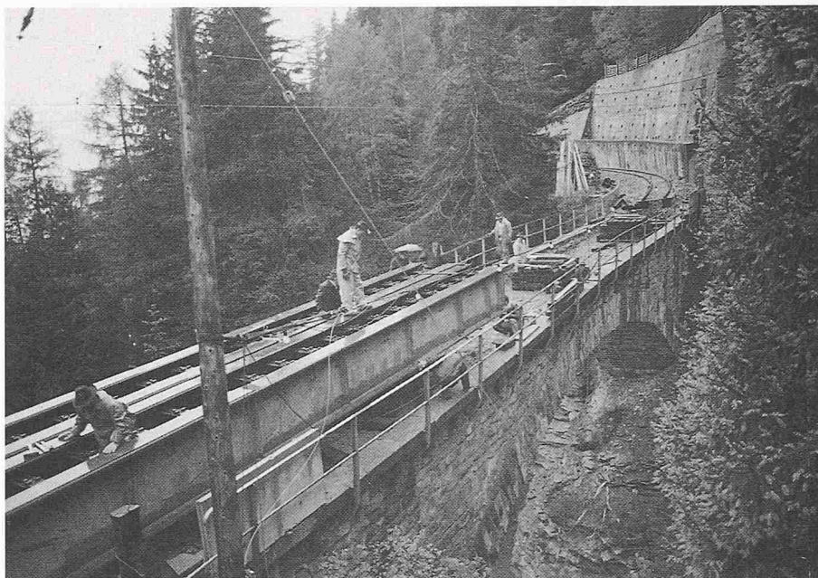
Bild 3. Einschub der Hilfsbrücke
