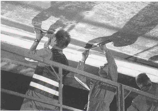
Nächtliche Sanierungsarbeiten an der Ibachbrücke: Nachdem die Betonoberfläche für die Applikation von drei CFK-Lamellen vorbereitet worden ist, wird hier die erste Lamelle angepresst
