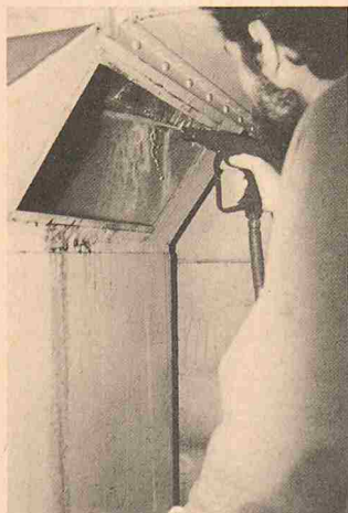
Der Wasserstrahl schießt mit Hochdruck (200 bar) aus der Pistole und löst den hartnäckigen Schmutz
