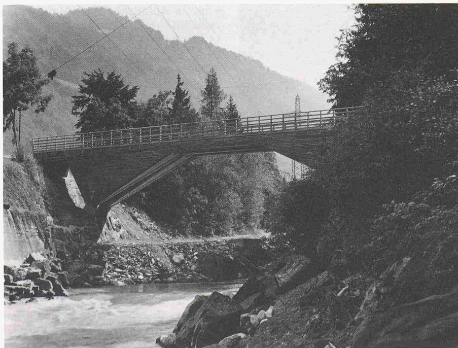
«Sagastäg»-Brücke über die Landquart
