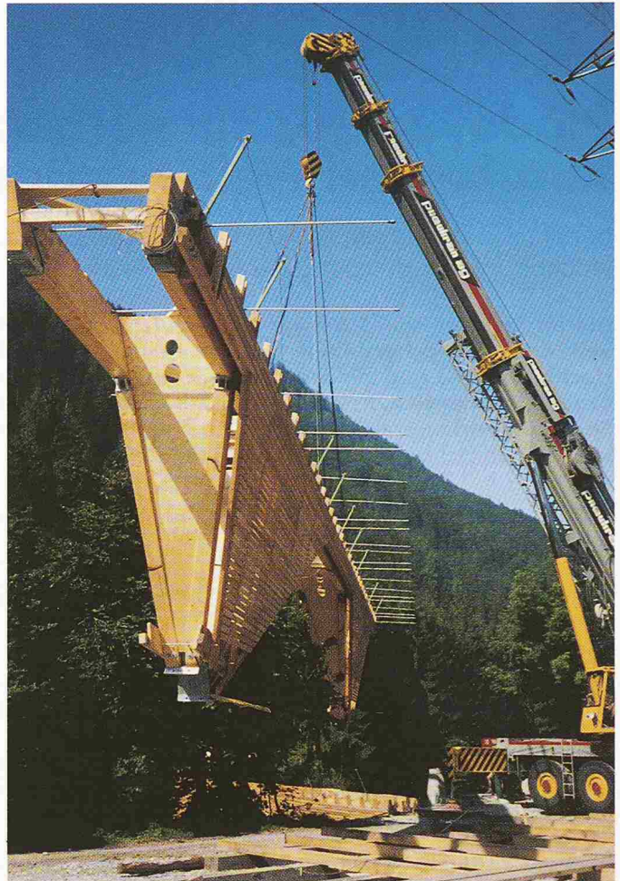
Eine Trägerhälfte wird angehoben
