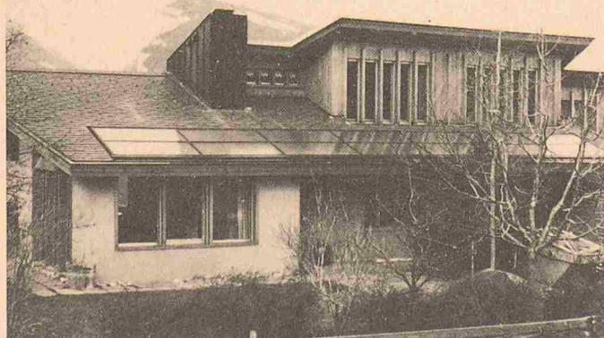
Ins Dach integrierte Sonnenkollektoren bei einem Gebäude in Aesch bei Spiez
