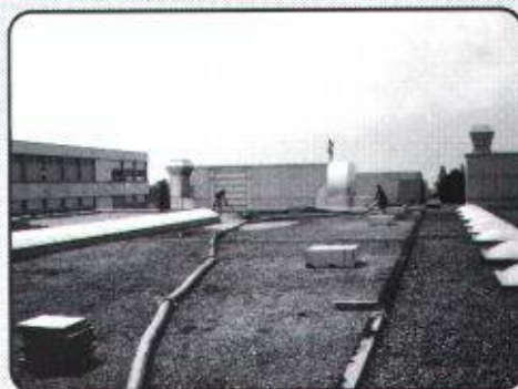
Absaugen von Kies, Sand und Humus ab Flach- dach, bei Baustellen und Kellern mit erschwer- tem Zugang.
